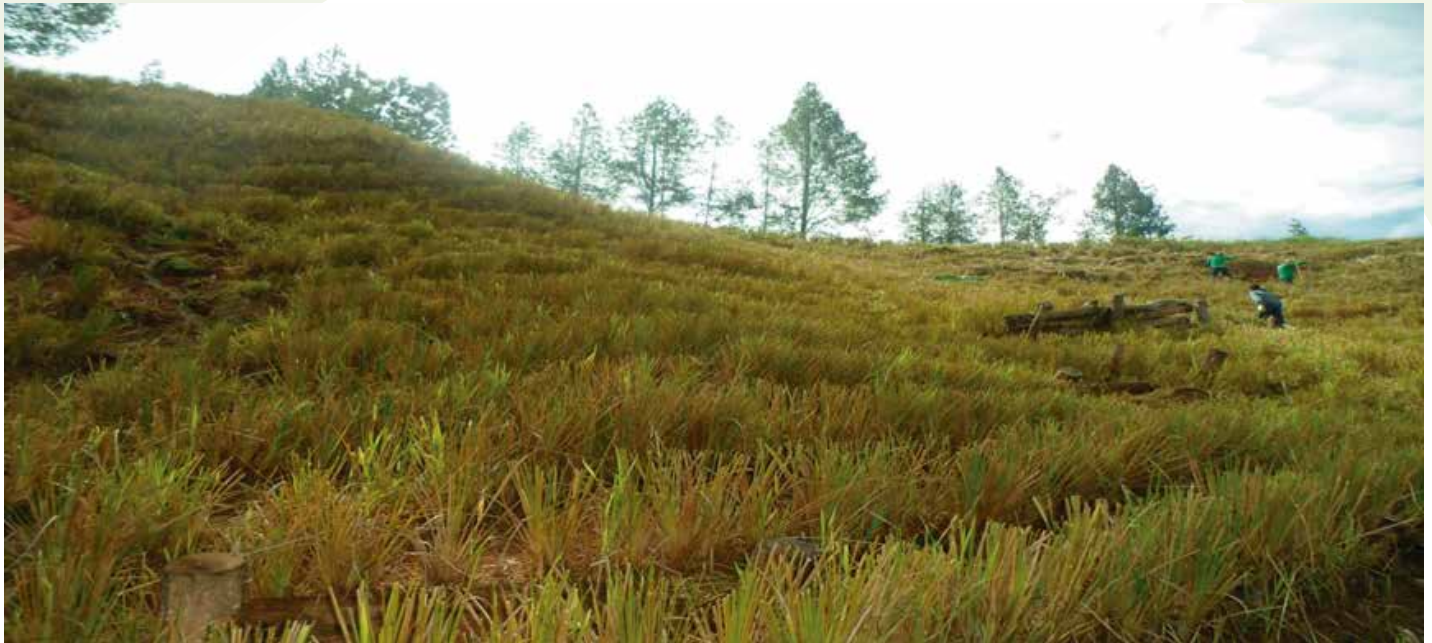
Estabilización talud con vetiver previamente Trincho en puntos críticos
