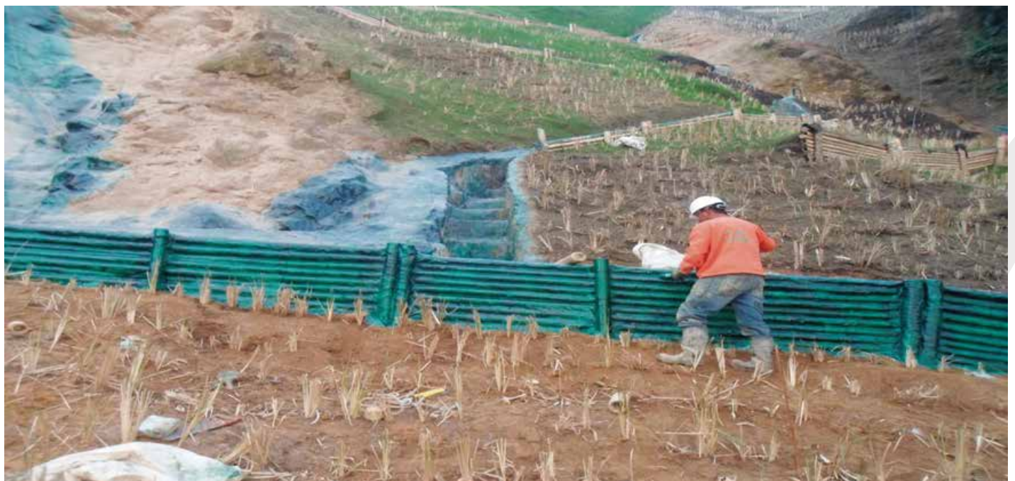
Manejo integral problema erosivo trinchos impermeabilizados con POLIMEZ
