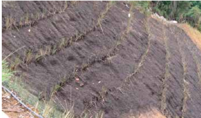
Fotografía 1. Aplicación biomortero entre líneas de pasto vetiver.
