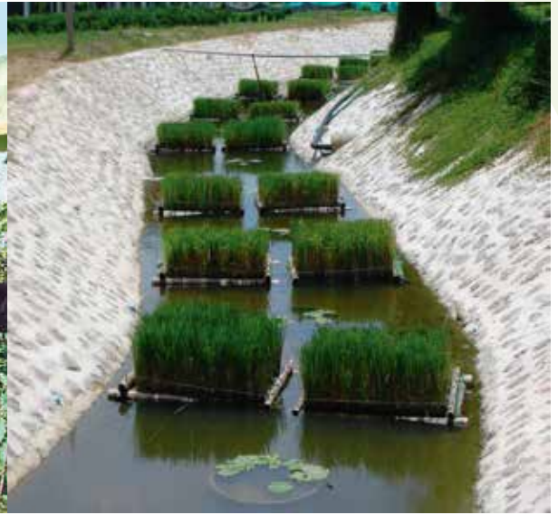
Biofiltros: tratamiento aguas .
