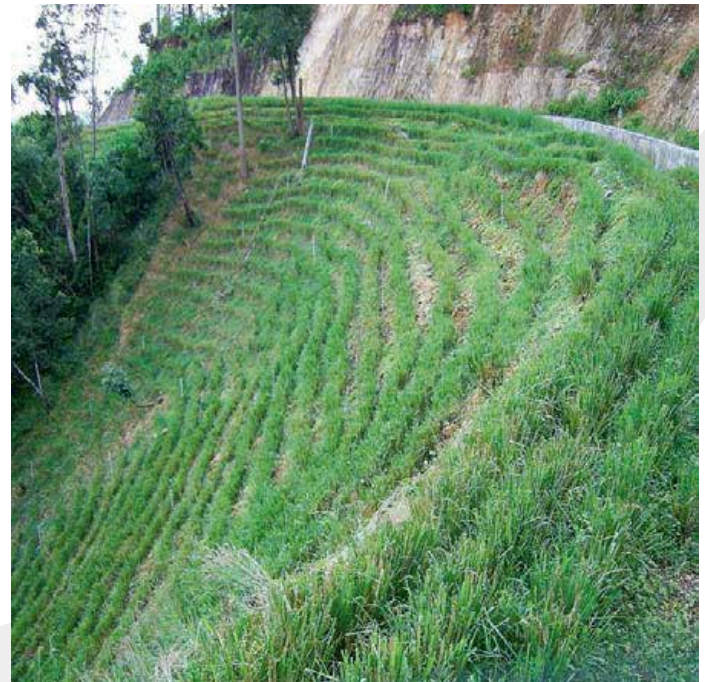
control erosión taludes corte /después
