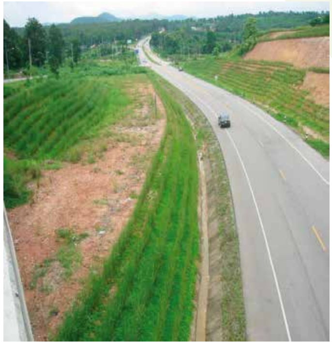
Foto: control erosión en vías
