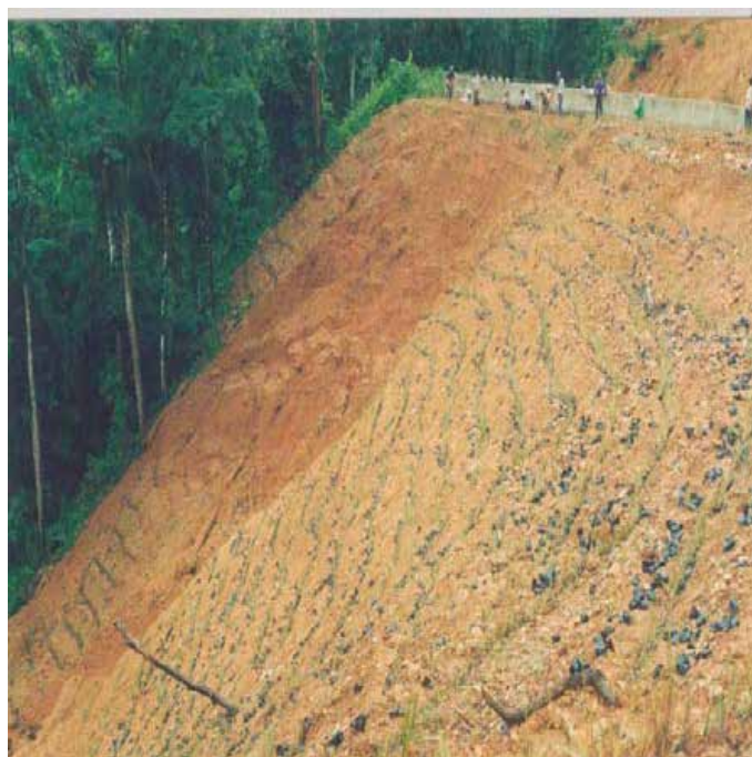
Control erosión taludes de corte (antes)
